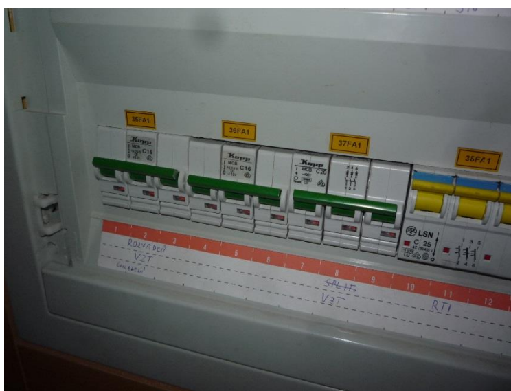
Stávající jištění VZT v rozvaděči RRO
